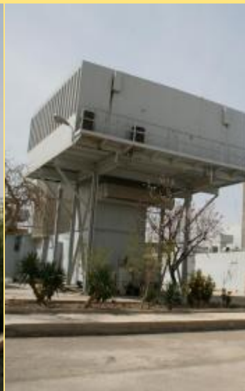
نمایی از نیروگاه گازی هسا
