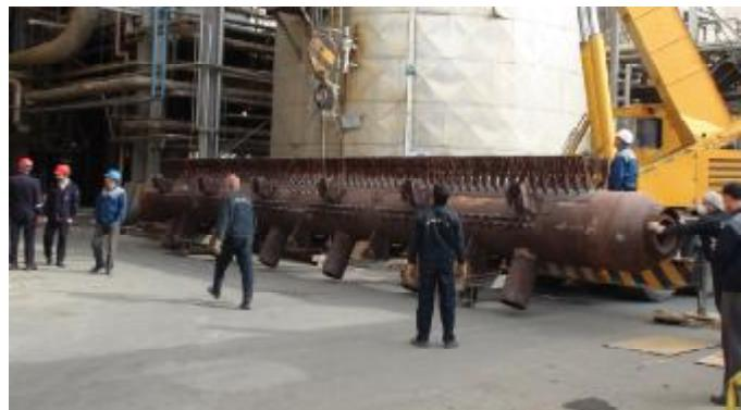
در این عملیات تعمیرات اساسی، طبق برنامه زمانبندی، بازبینی و سرویس کامل تجهیزات اصلی این واحد شامل: بویلر، توربین، ژنراتور و سایر تجهیزات جانبی آن انجام شد و همچنین پره های متحرک کورتیس ردیف اول توربین فشارقوی تعویض و بالанс آن انجام گردید.
