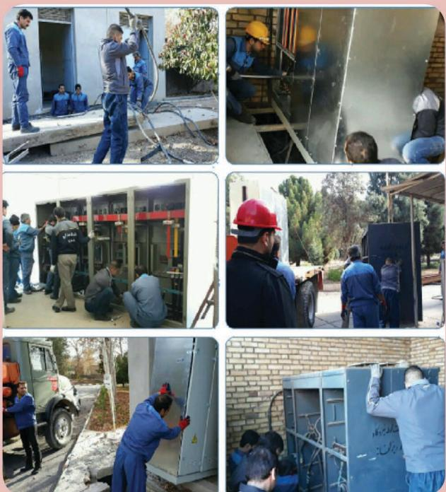
گفتنی است از مدار خارج کردن کلیدهای با عمر بالا، حفاظت الکتریکی بهتر با توجه به عملکرد حفاظتی غیرقابل قبول برخی از کلیدها، کور دینه کردن حفاظتی کلیدهای بالادرستی و پایین درستی و افزایش قابلیت اطمینان پست ها از مهمترین دلایل انجام پروژه مذکور می باشد.
